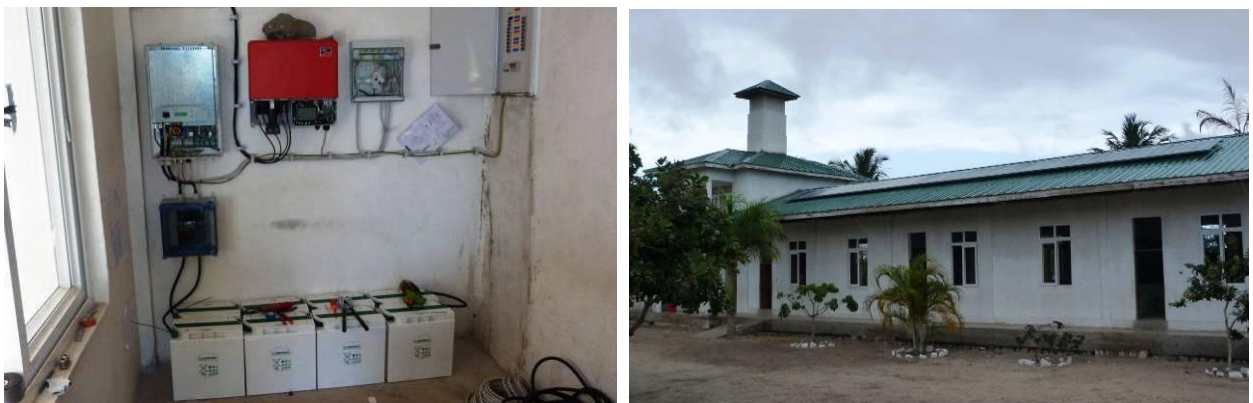
Die neue Photovoltaik-Anlage auf der Mwasama-Schule (Okt. 2012)
